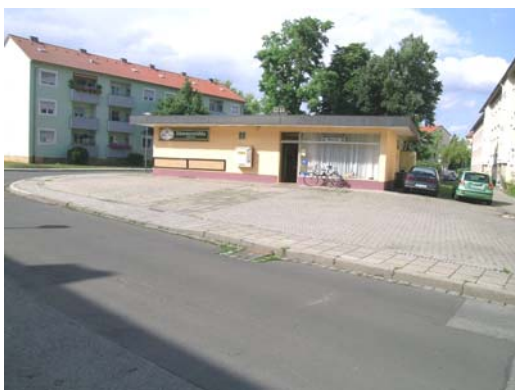
Abb. 47: Kreuzungsbereich Elsterweg/Mohnstraße mit 1-geschossigem Gebäude (Imbiss/Gaststätte)
