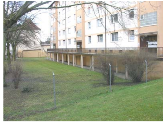
Abb. 22: Garagenanlage mit Freiflächen im Rückbereich der Hedwigstraße
