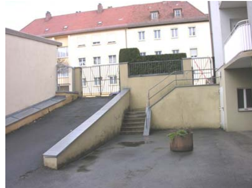
Abb. 68: Zugang zu den Grundstücken der Siedlungsgenossenschaft in der Hirschbühlstraße
