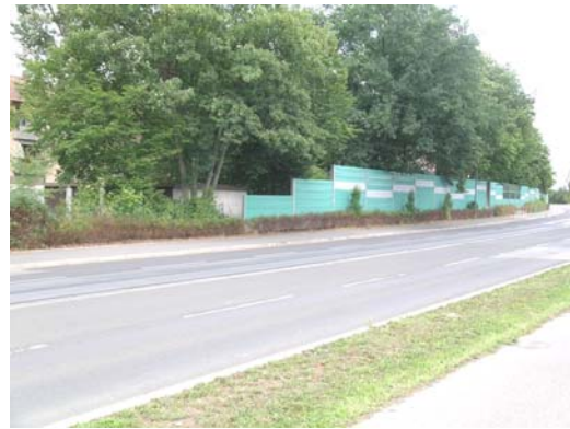
Abb. 78: Forchheimer Straße mit Lärmschutzwand
