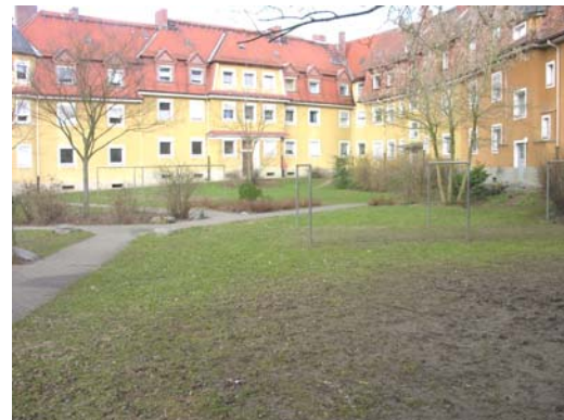
Abb. 28: Rückwärtige Seite der Hüttenfeldstraße mit Grünfläche
