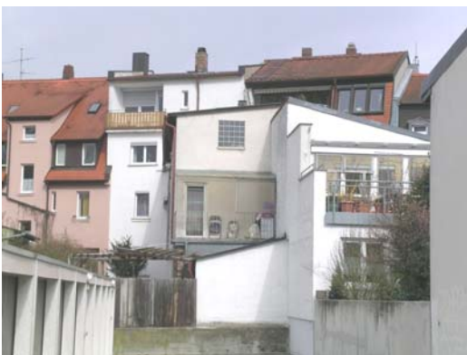
Abb. 60: Rückwärtige Bebauung an der Erlichstraße
