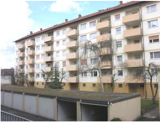
Abb. 21: Wohngebäude Hedwigstraße (Rückbereich) mit Garagen
