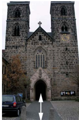
Eingang und Vorplatz St. Gangolf
