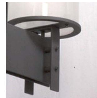
Befestigungsdetail eines Glaszylinders nach altem Vorbild
