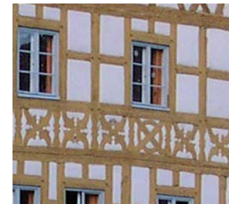
Holz im Fachwerk
