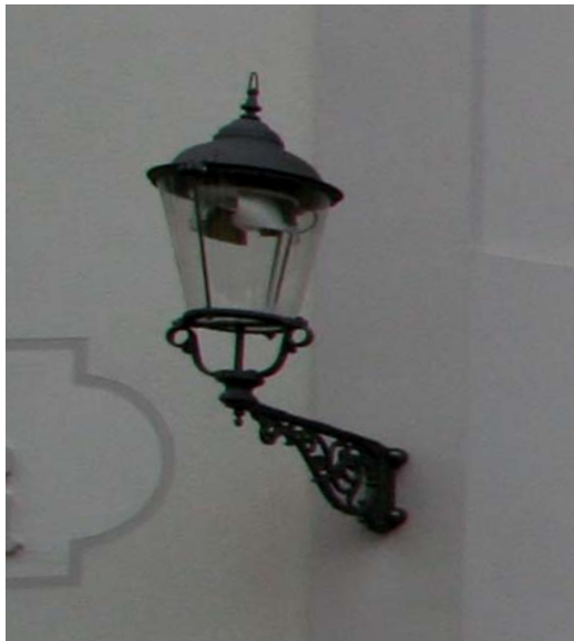
Beispiel einer historisierenden Stadtleuchte mit moderner Lichttechnik
