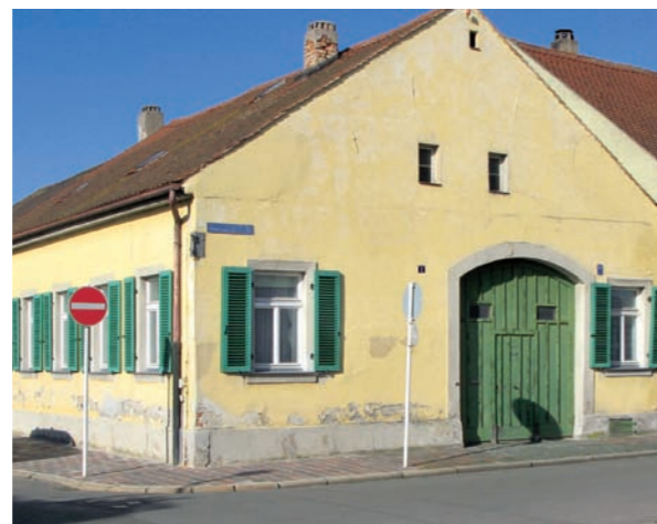
Bild oben links: Ehemaliges Bahn- betriebsgebäude aus der Entste- hungszeit des Bahnhofs (1842) in der Brennerstraße
