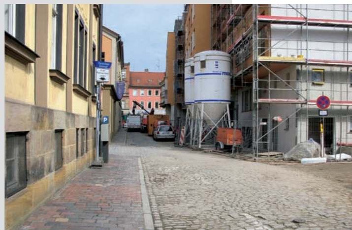
Neubauten und Straßenraumgestaltung in der Trännergasse
