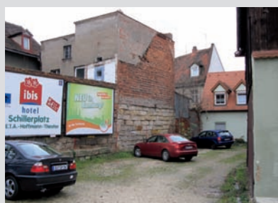
Sanierungsbedarf ist häufig mit Funktionsverlusten verbunden
